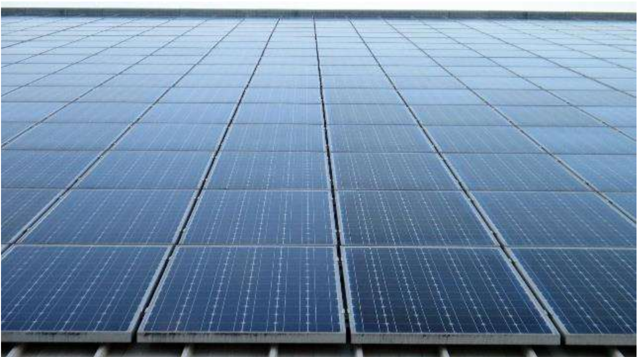
Fig. 1 - Installazione di pannelli fotovoltaici.
