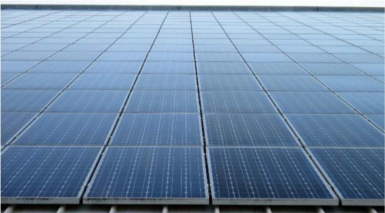
Sl. 1 - Inštalacija fotovoltaičnih panelov.
